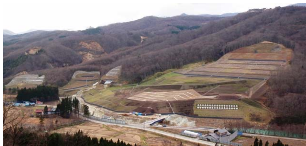
写真5—災害復旧工事完成の様子（平成22年12月8日撮影）
