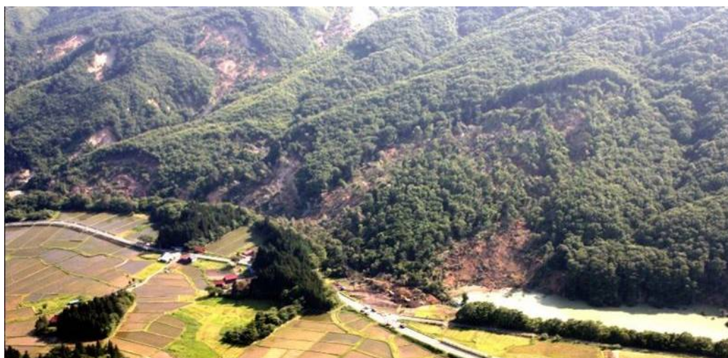
写真4—地すべり直後の様子（平成20年6月18日撮影）
