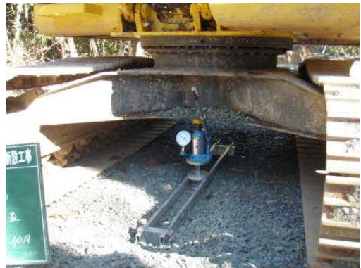
写真5. 支持力の調査状況
