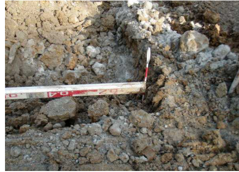
写真4. 施工厚さの管理状況
