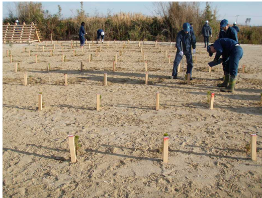
写真－4 植栽作業中
