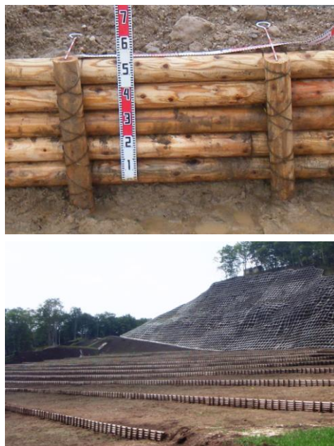
写真-1 丸太柵工等の施工状況
