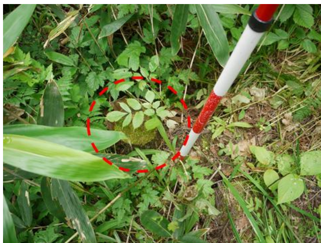
写真 7. 施工後 4 年経過した土留根株
