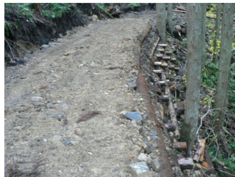
写真 2. 丸太組みの施工例
