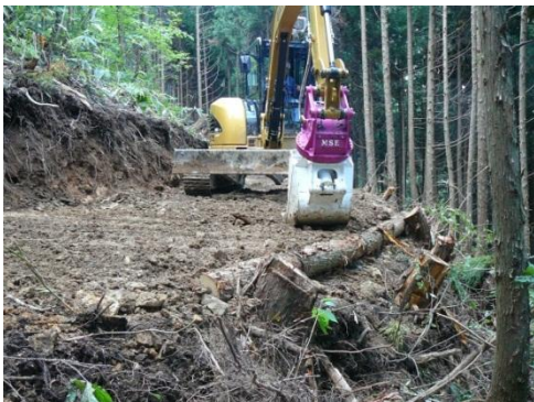
写真 1. 土留根株の施工例
