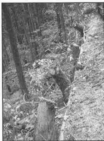
図-1 伐根土留工
