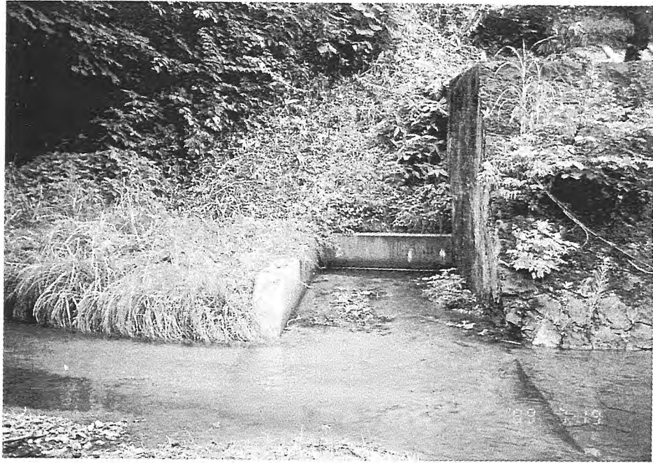
写- 1 (魚道出口の堆砂状況 )
