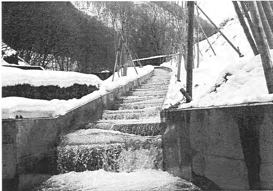
写- 2 (魚道から水が溢れた状況)
