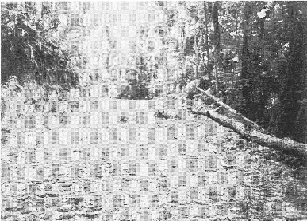
写真-3 路体完成状況
