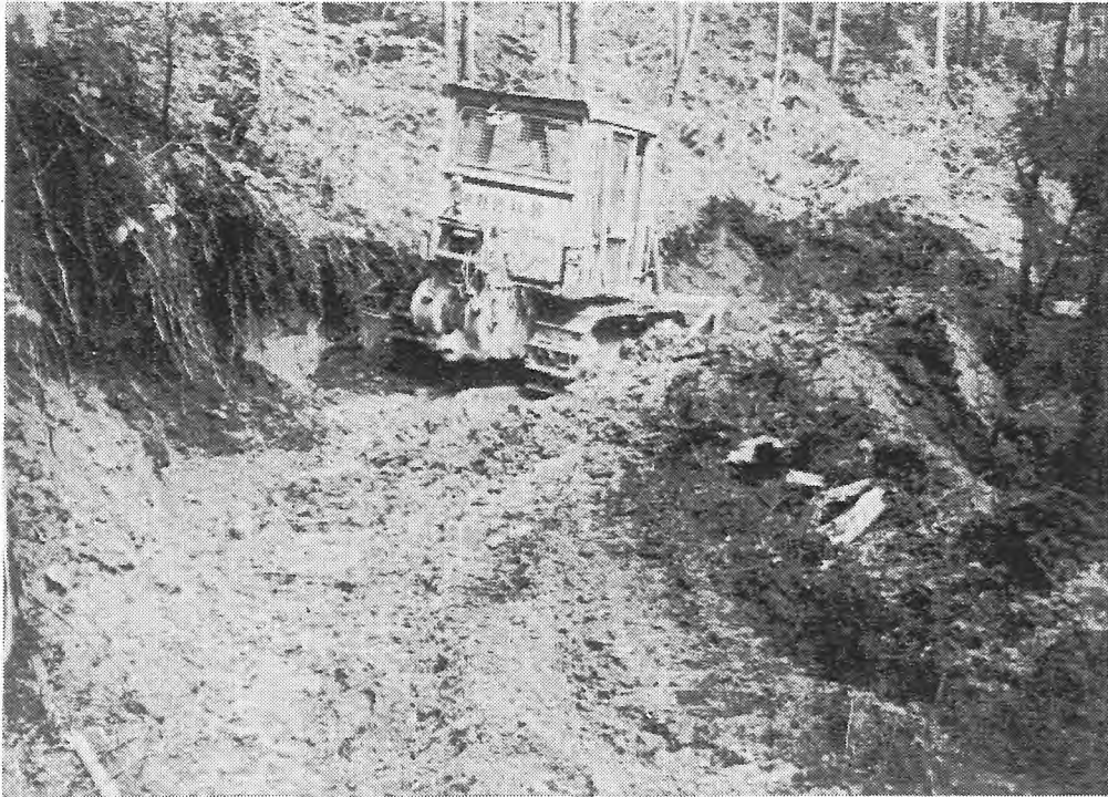
写真-2 路体作設状況
