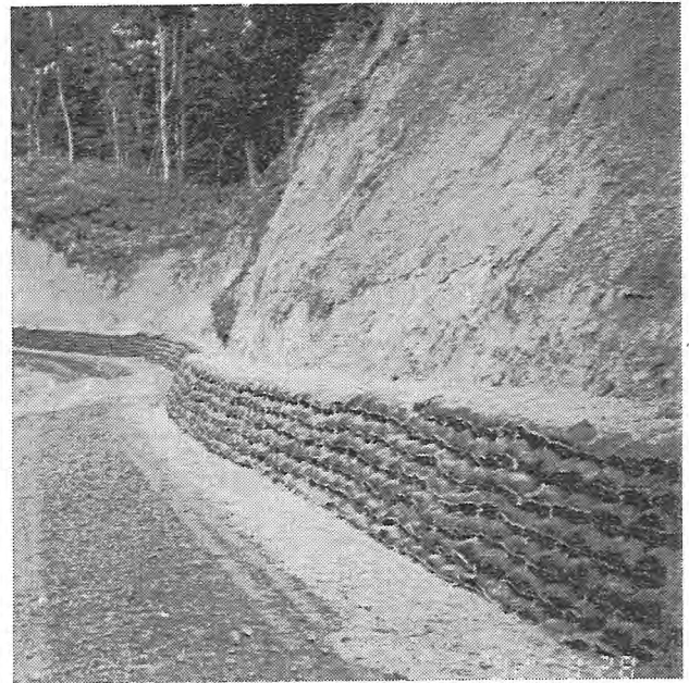
(写-8) 土のう積工、積高1、0 mで完成
