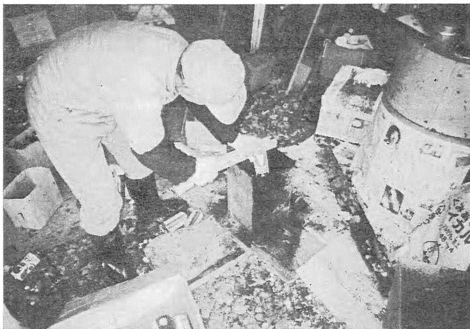
写真-4 簡易穴開け機による作業風景
