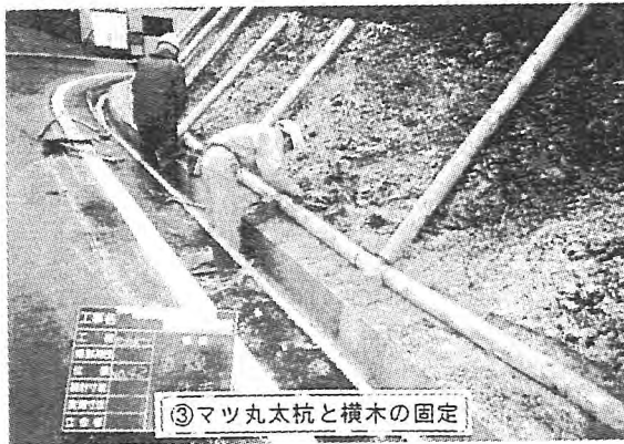
写真-1 西工区の丸太伏工の施工状況
