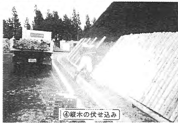
写真-1 西工区の丸太伏工の施工状況
