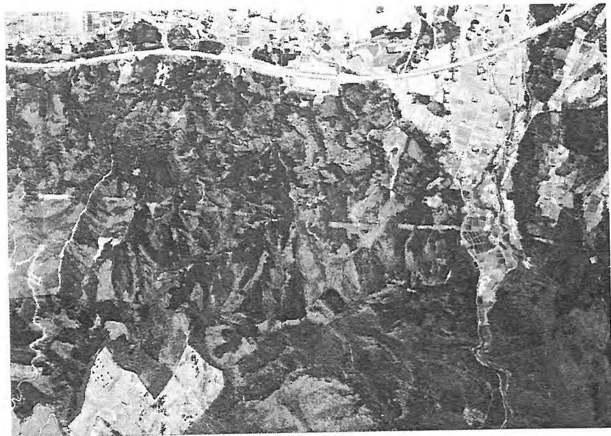
写-4 被災後の全容 空からの写真
