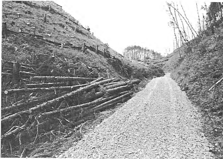
写-13 県作設の作業道
