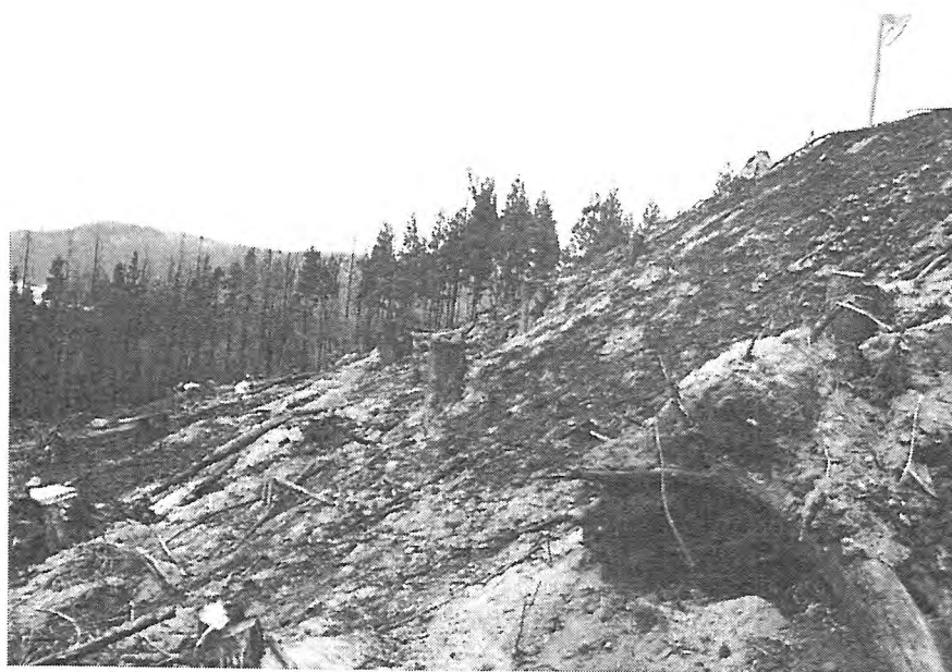
写-10 現在の復旧状況 緑化前
