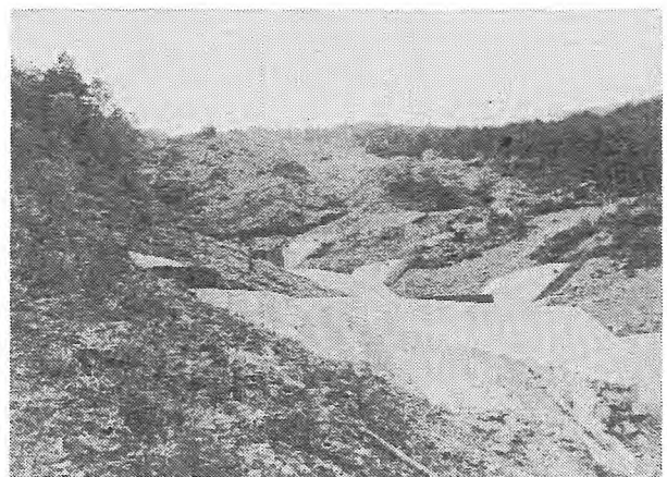
写-1 施工地の現況
