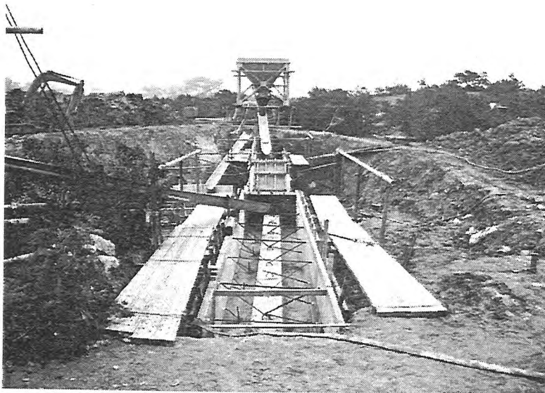
型枠取付完了状況
