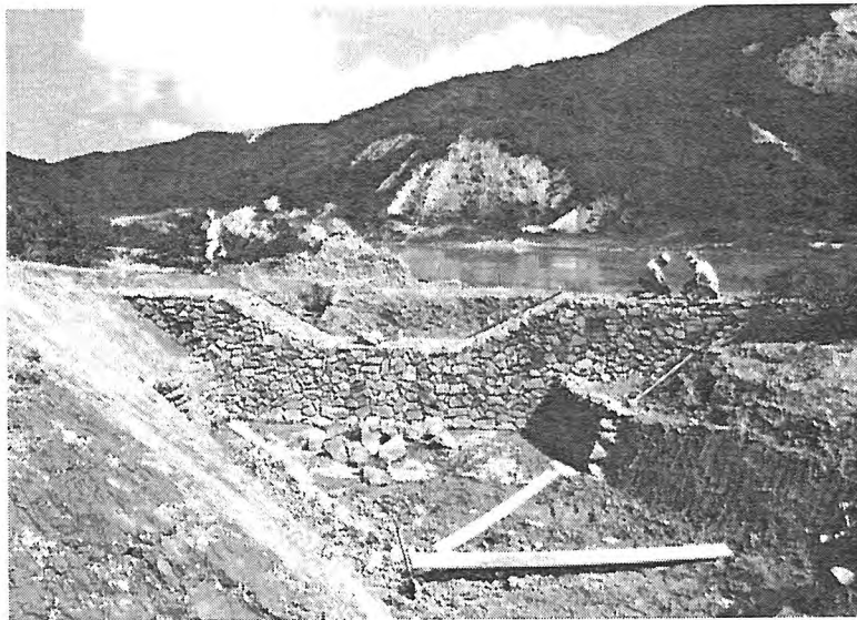
2号床固工 積石張石完了状況
