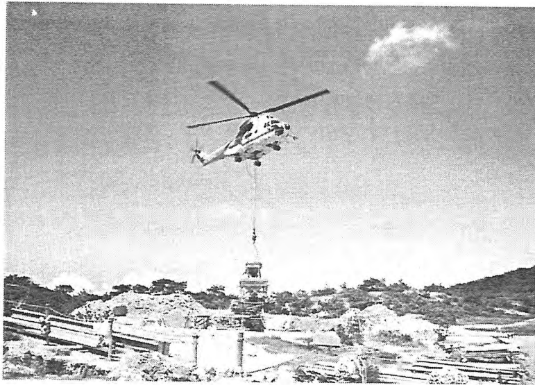
ヘリによるコンクリート運搬状況
