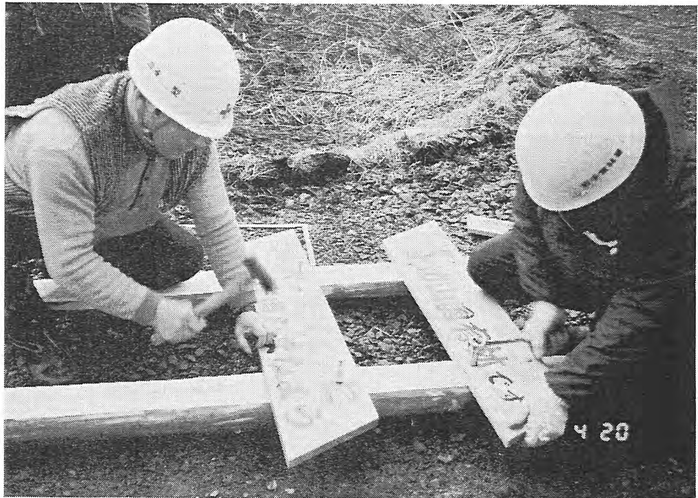
(写-2) 現場での組立て
