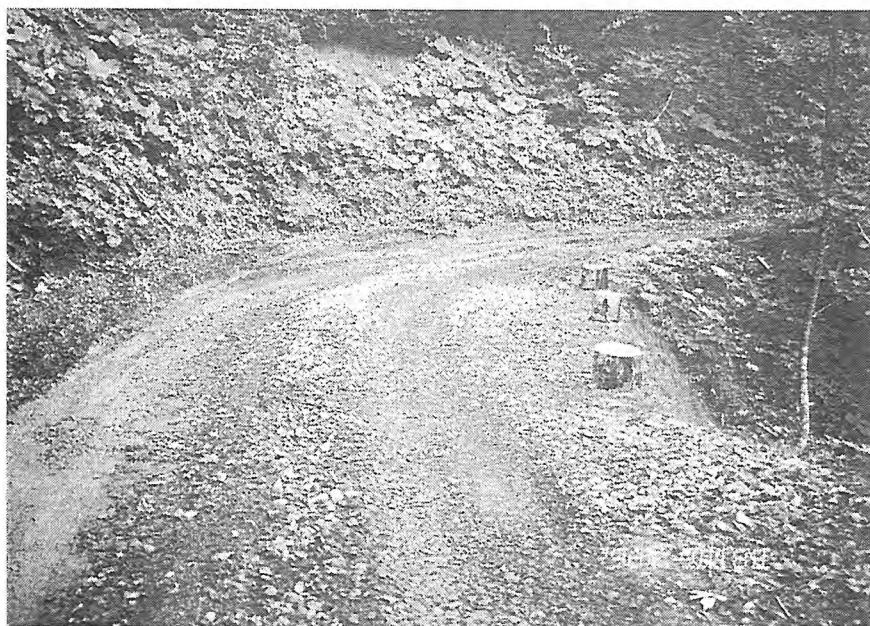
写真-2 実行番号3号 完成写真(林道路面右侧)
