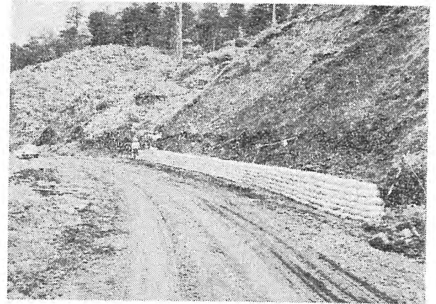
(写-7) 土のう積施工中
