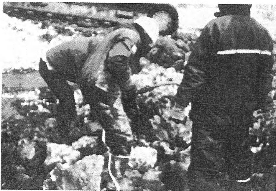
ウタアナ沢練石積治山ダム取り壊し作業状況
