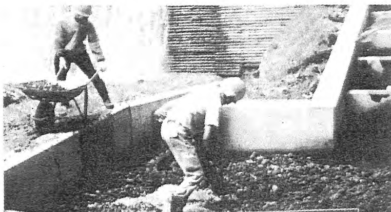
魚道プール内の流出土砂の取除作業状況 スライドNO. 10
