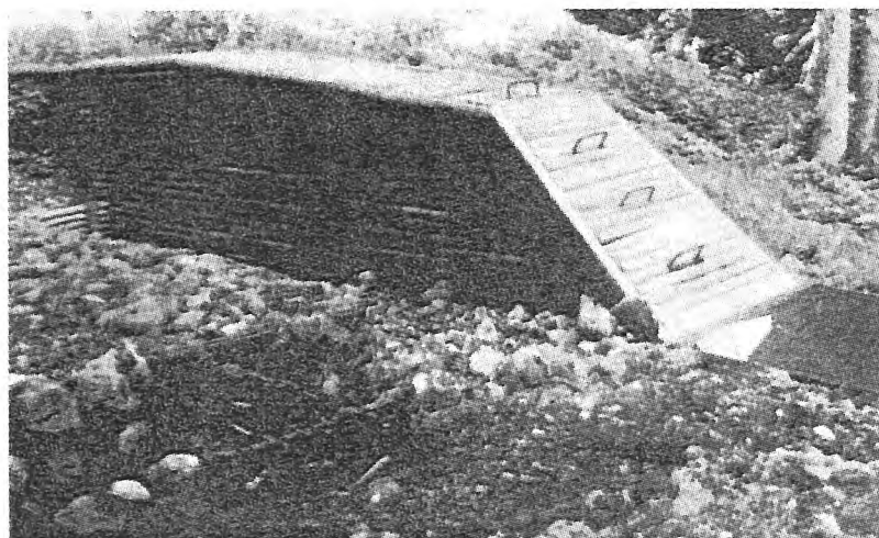
魚道内に流出土砂が堆積し出口プールが閉塞している状況 スライドNO. 9
