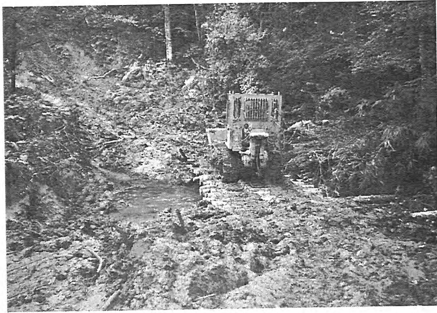
写真一 3 簡易な橋の横断状況
