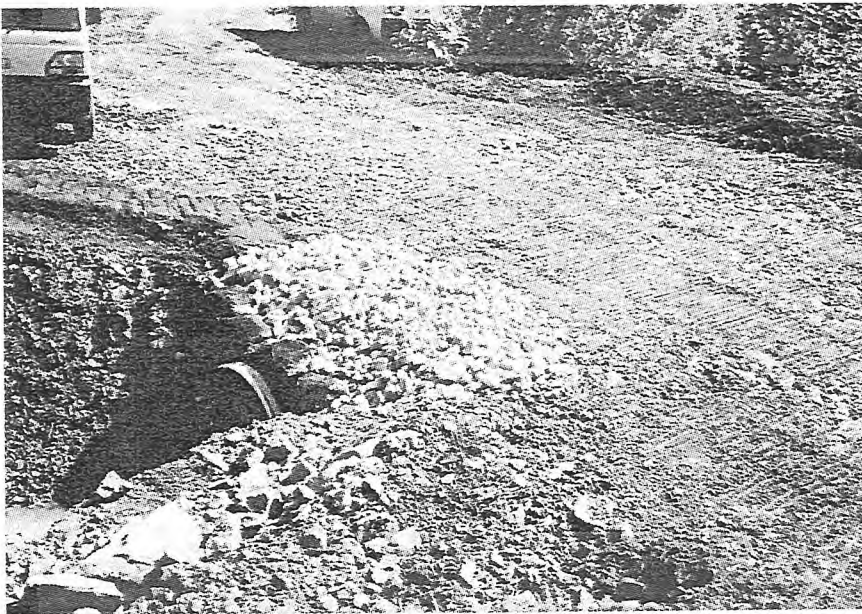
コルゲートパイプの設置完成です。
