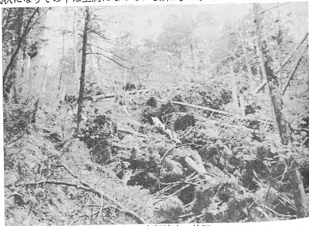
写真-1 上部被害の状況
