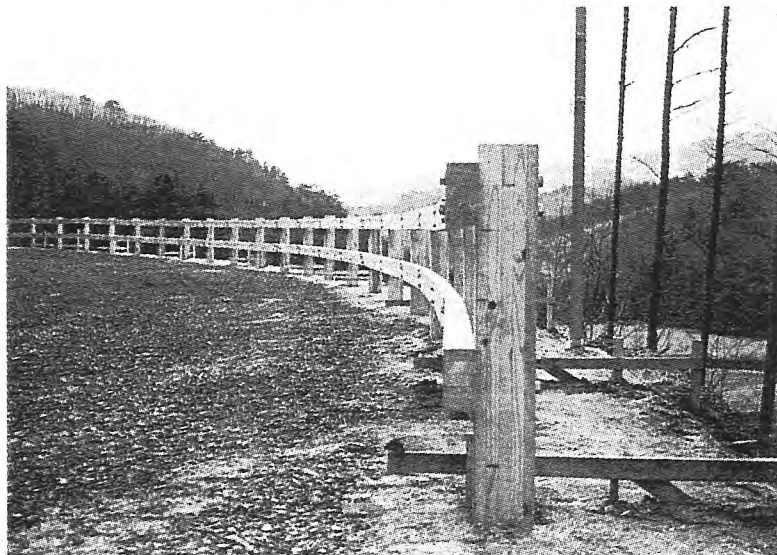
写-12 木製ガードレールの使用状況
