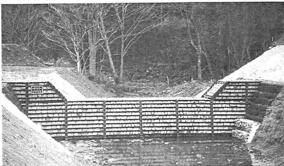
(写真-9) 完成 (下流から)
