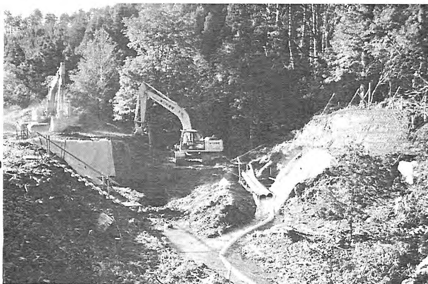
(写真-6) 施工中 (床掘)
