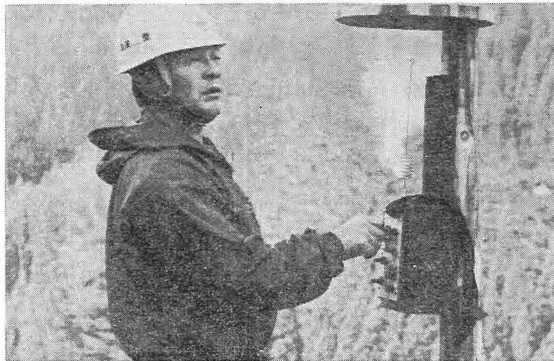
(写-3) ラジコンの操作状況
