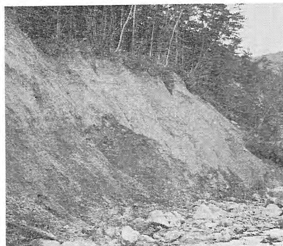
写-6 溪岸崩壊の状況
