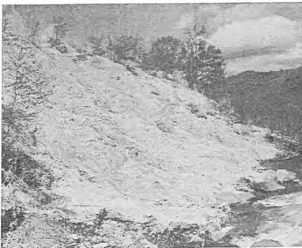
写-1 着手前の状況
