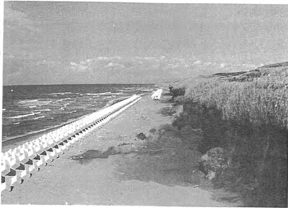
写-2 根固ブロックと後背地状況
