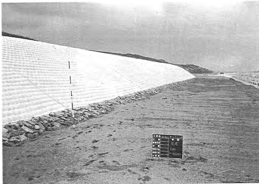
写-4 完成後の堆砂状況
