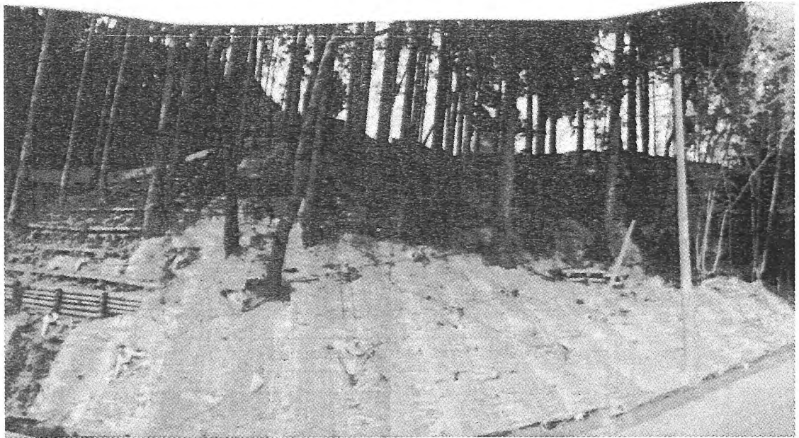
写-7 施工直後の全景
