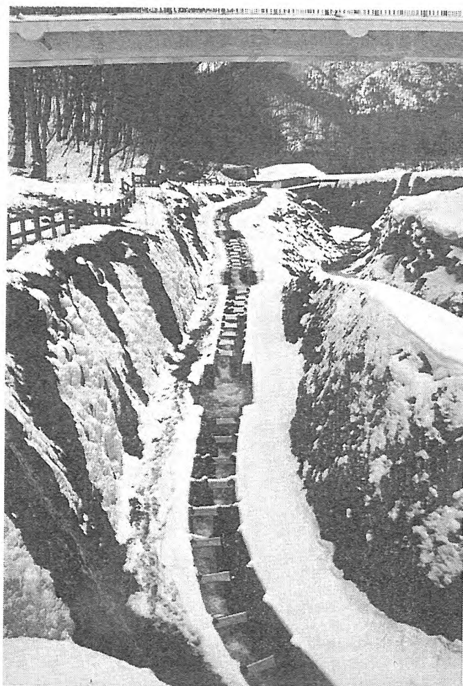
写-2 川内川東北電力取水堤の魚道
