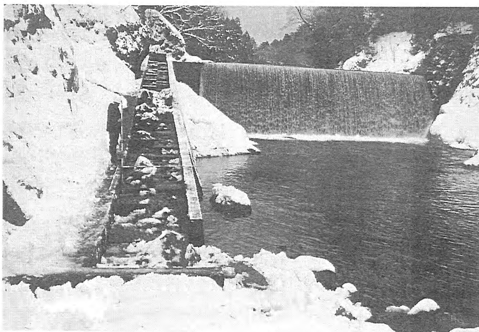
写-5 大畑川砂防ダムの魚道（イ）
