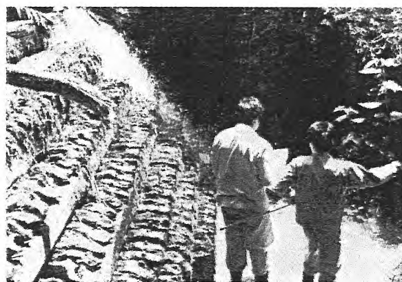
図8 下流法面状況
