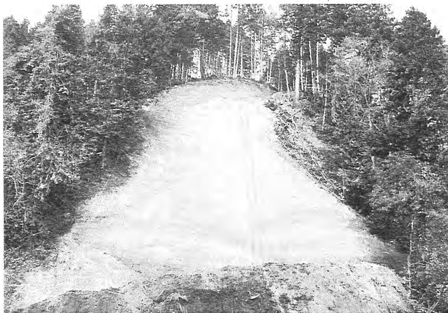
写真 - 3 丸太伏 施工中
