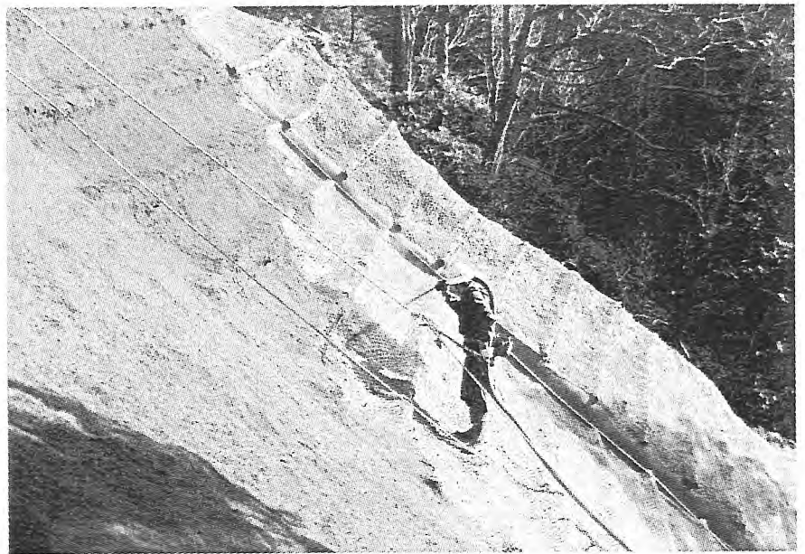
写真 - 8 団粒土厚層基材吹付中
