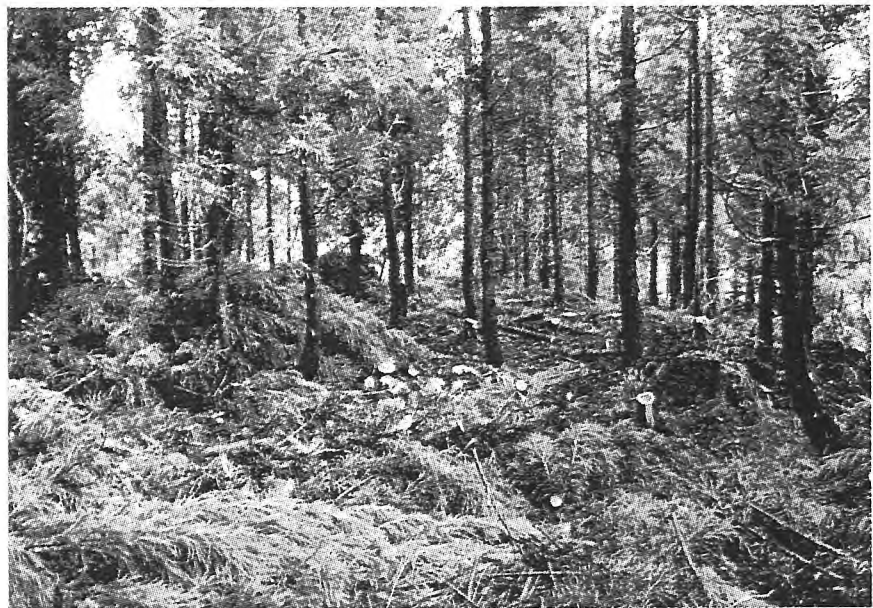
写真 - 11 本数調整伐実行状況
