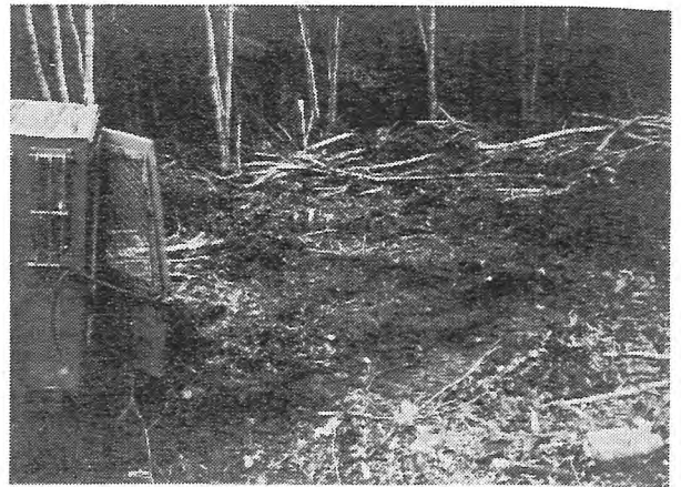
写-1 支障木の処理状況
