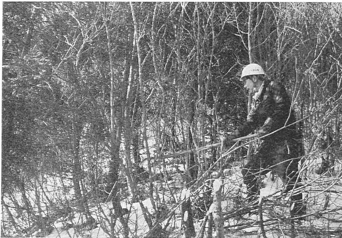
〔写-5〕 除伐木を除去している状況、押し除いている状況
