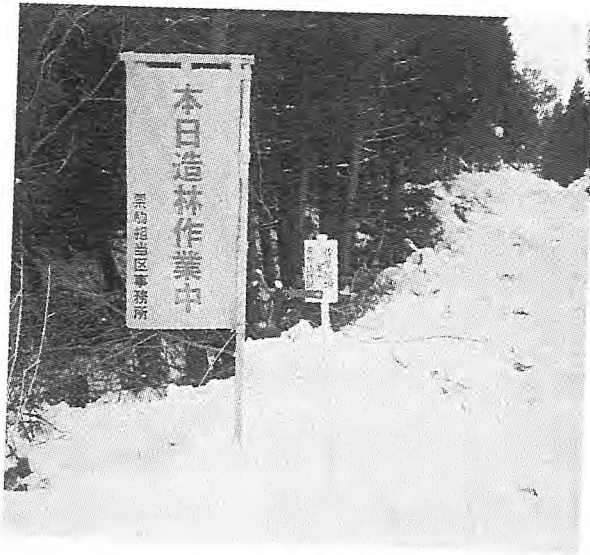
写-8 作業現場案内板
