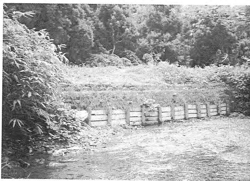
写-9 復旧工事完成（2ヶ月後）の状況
