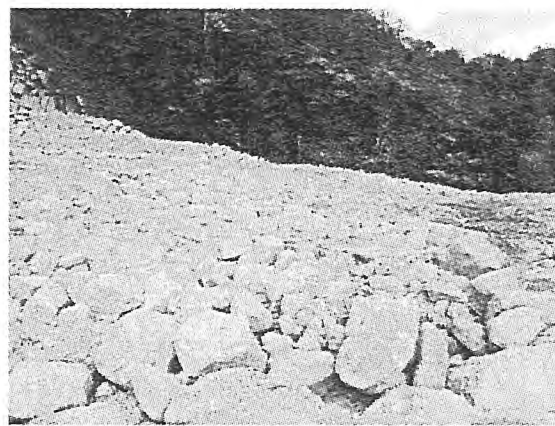
写真-11 緩傾斜地の埋め戻し状況
