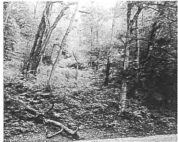
写真-7 国道102号沿いの施工地全景
