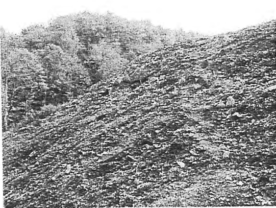
写真-14 H13年10月の植生進入状況
