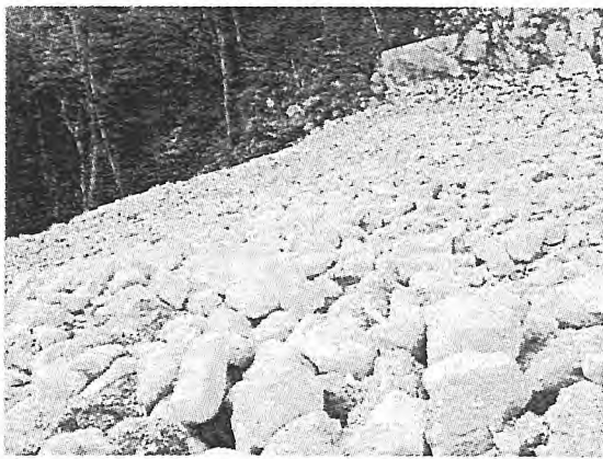
写真-10 急傾斜地の岩塊埋め戻し状況
