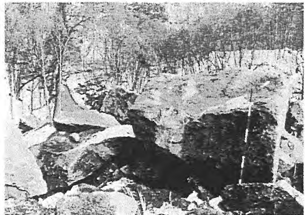
写真-2 崩落岩塊近況
