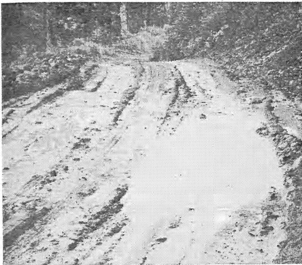
写真-3, 4 (横断排水溝設置以前の林道の状態)
