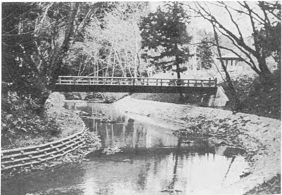
写-2 キャンプ場周辺の護岸工
