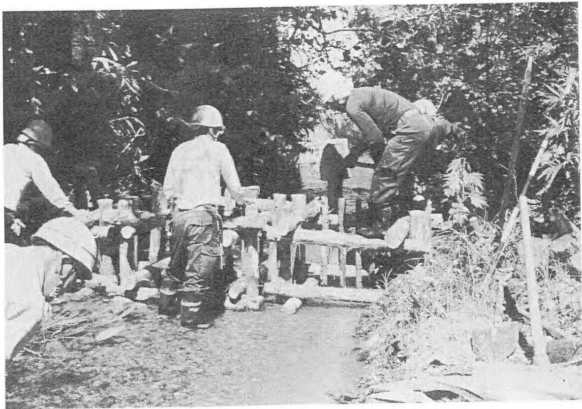
写-16 丸太枠組立て状況
