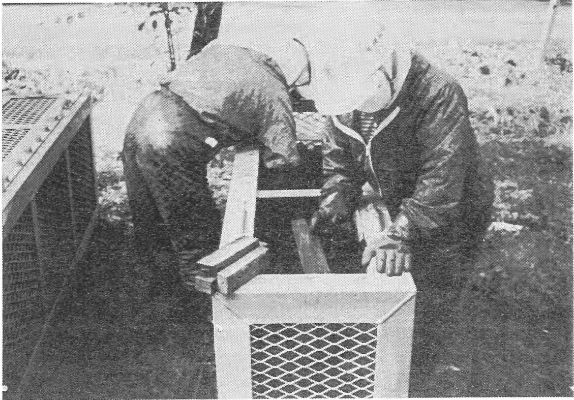
写-11 木炭詰込み状況
