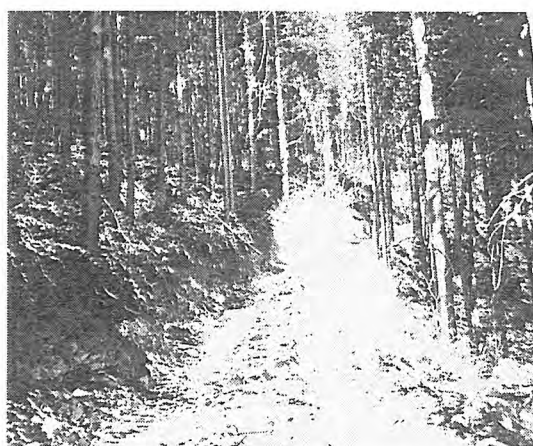
写真-3 幹線作設状況
