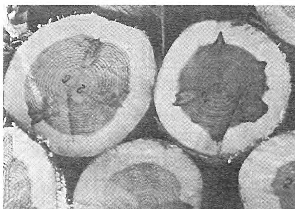
写-2 木口の状況
