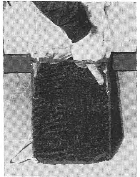
〔写真-4〕 ゴム輪つきフックの取り付け
