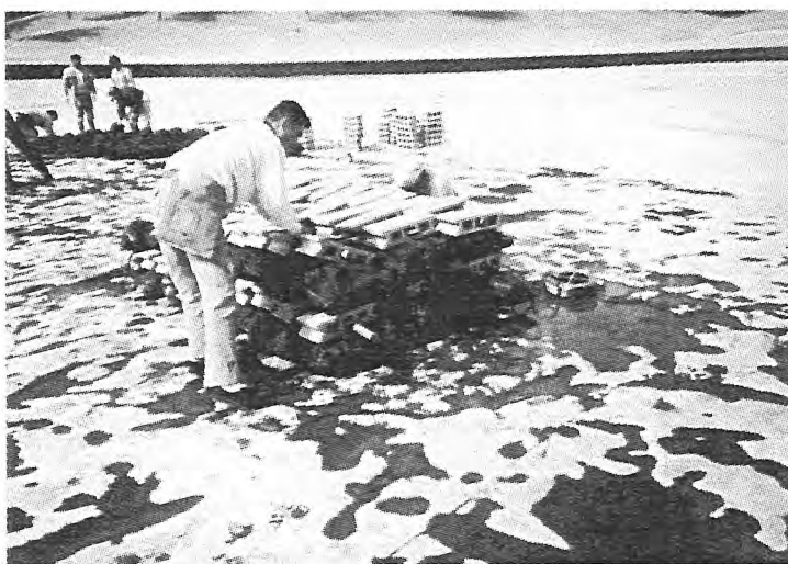
(写-2) ゴルフ場池への木炭設置状況
