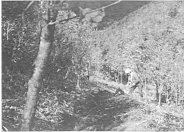
写-3 唐鍬による路面作設の様子
