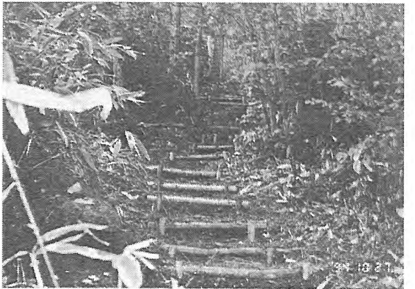
写-8 完成後 急傾斜地の階段工
