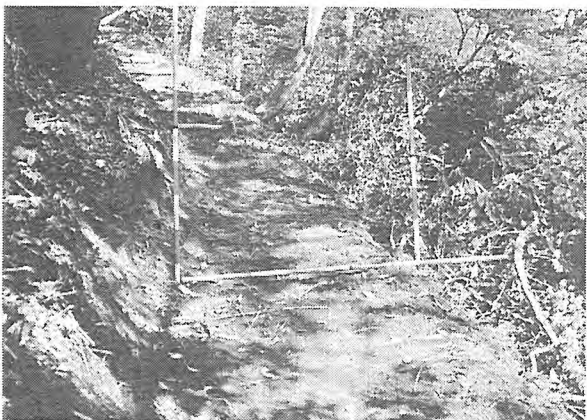
写-5 完成後 路面幅の様子
