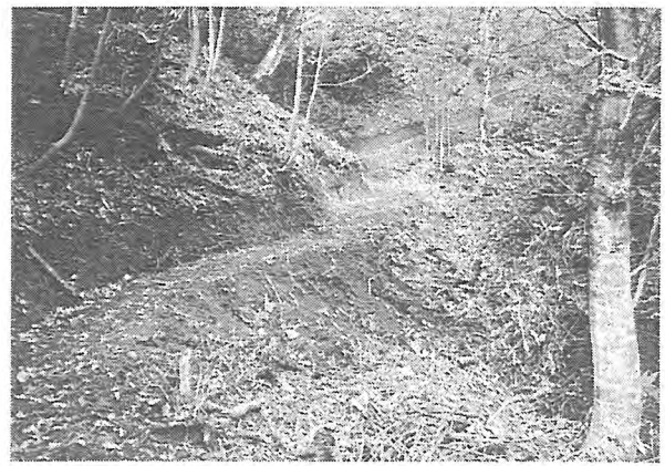
写-4 完成後 傾斜地を緩い勾配で登っていく
