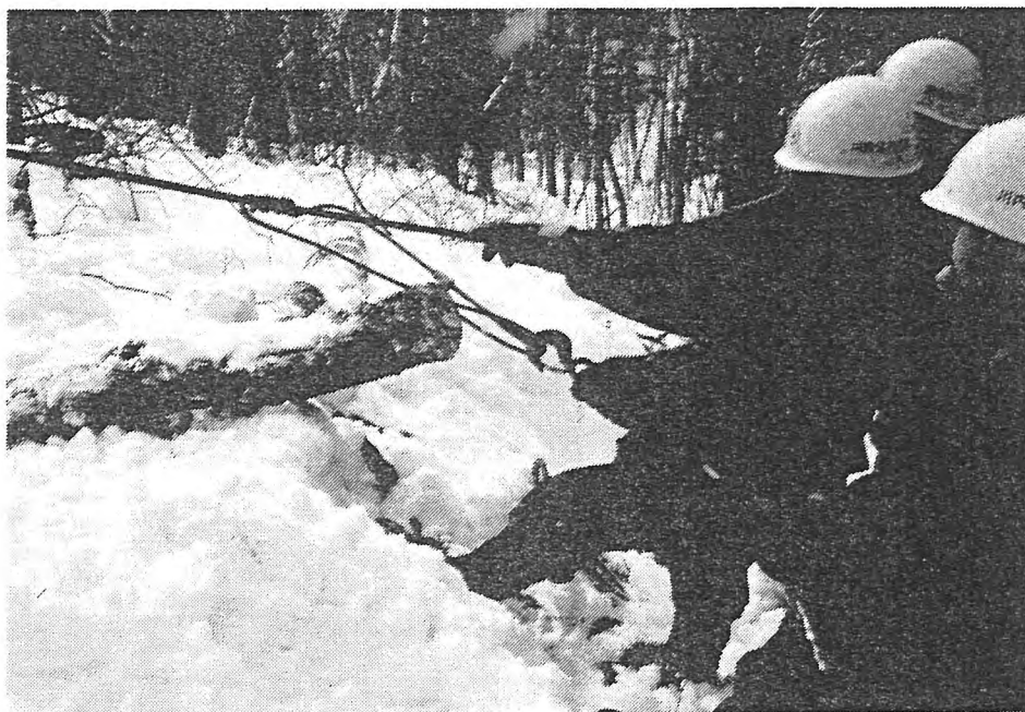
(写-7, 8) 荷掛け、荷はずし状況
