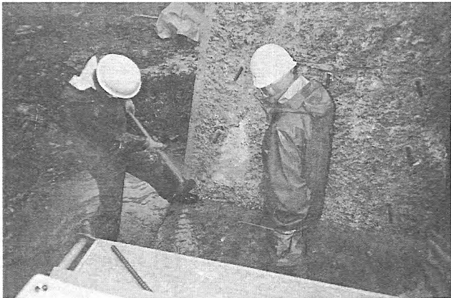
写-9 打継面のアンカー打ち込み状況
