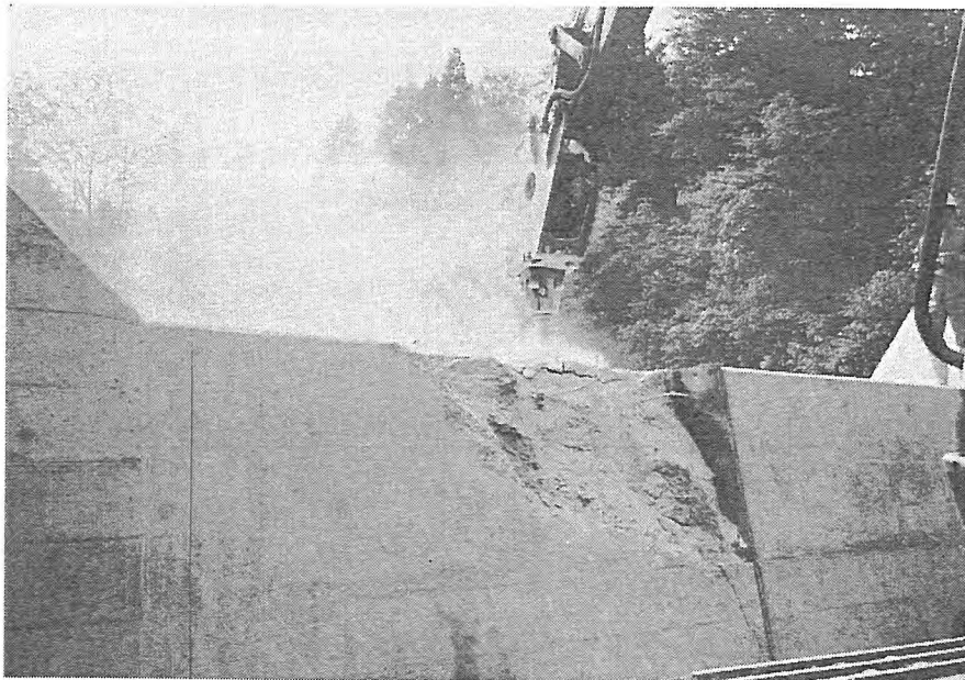
写-7 機械施行の状況
