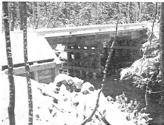
大場沢橋架け替え工事完了写真
