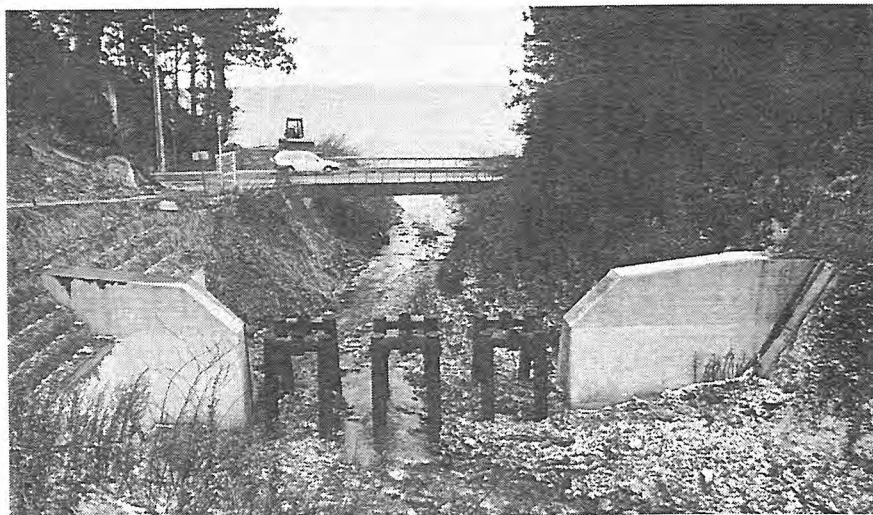
写-7 完成したスリットダム
