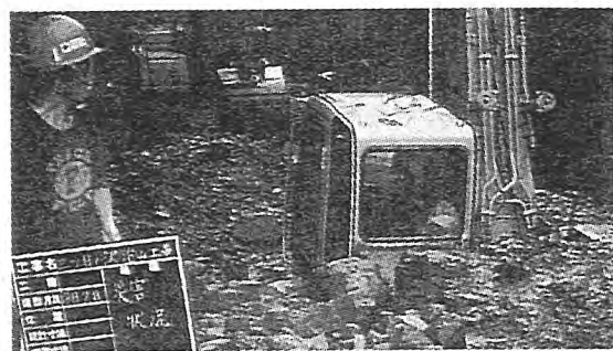
(建設機械埋没)
