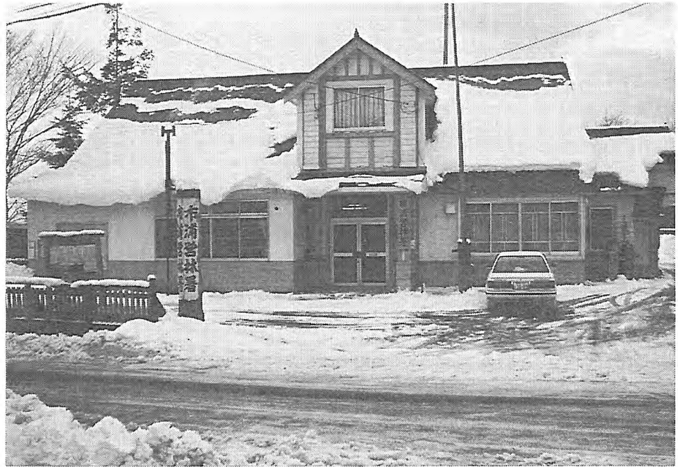
(写-1) 市浦営林署庁舎
