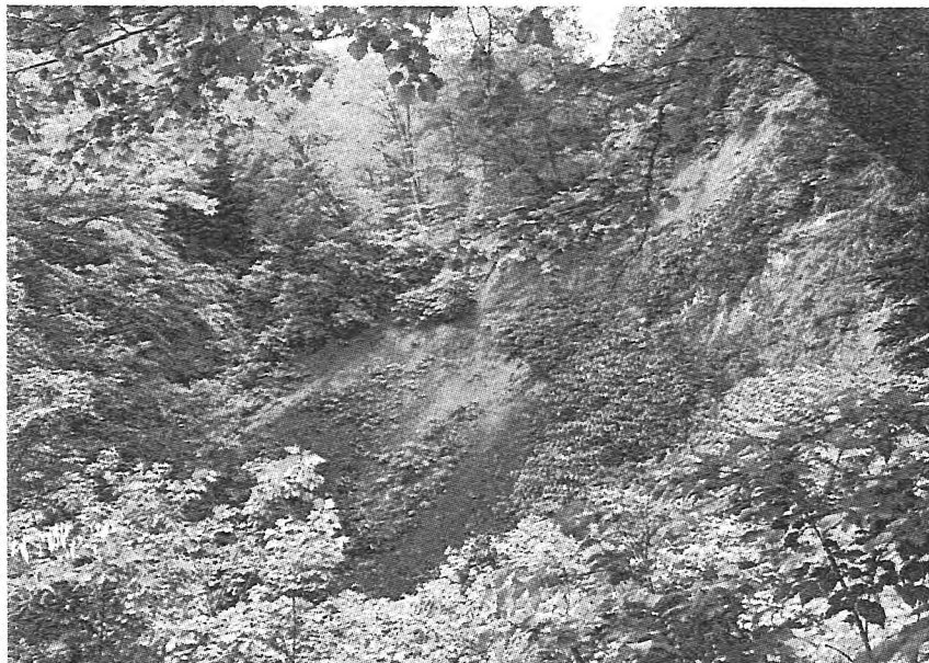
写真-6 沢沿い崩壊地への 実播状況
