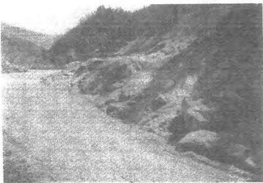
写真1 土留工設置前
