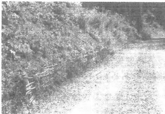
写真10 粗朶編柵工
