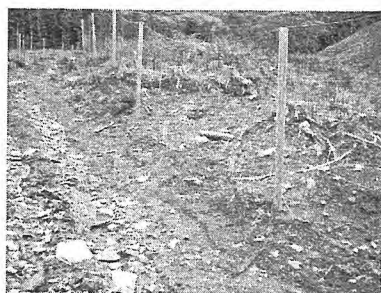
写真-3 木製支柱+ネット
